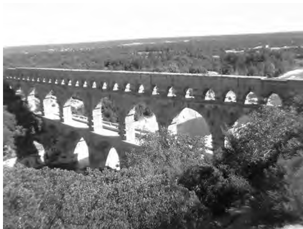
南仏古代ローマ水道橋「ポン・デュ・ガール遺跡」
